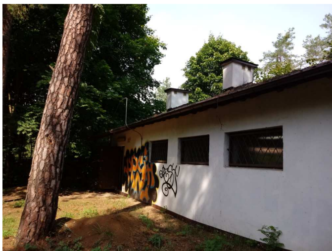
Widok budynku stacji od strony południowej.
